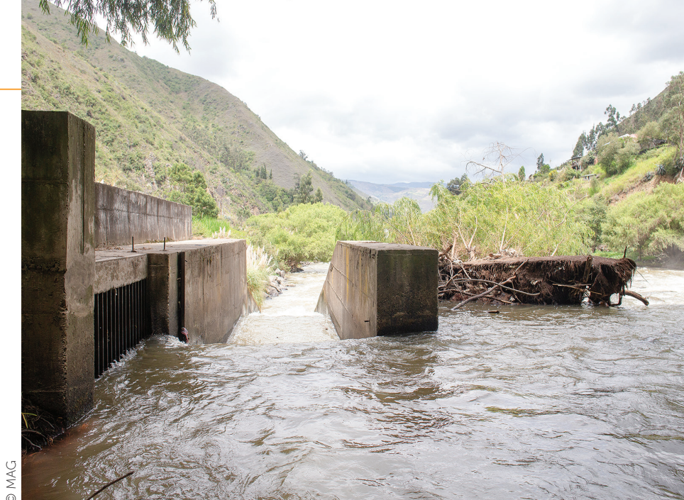
Paute - Azuay. Bocatoma del sistema de riego Guachapata.
