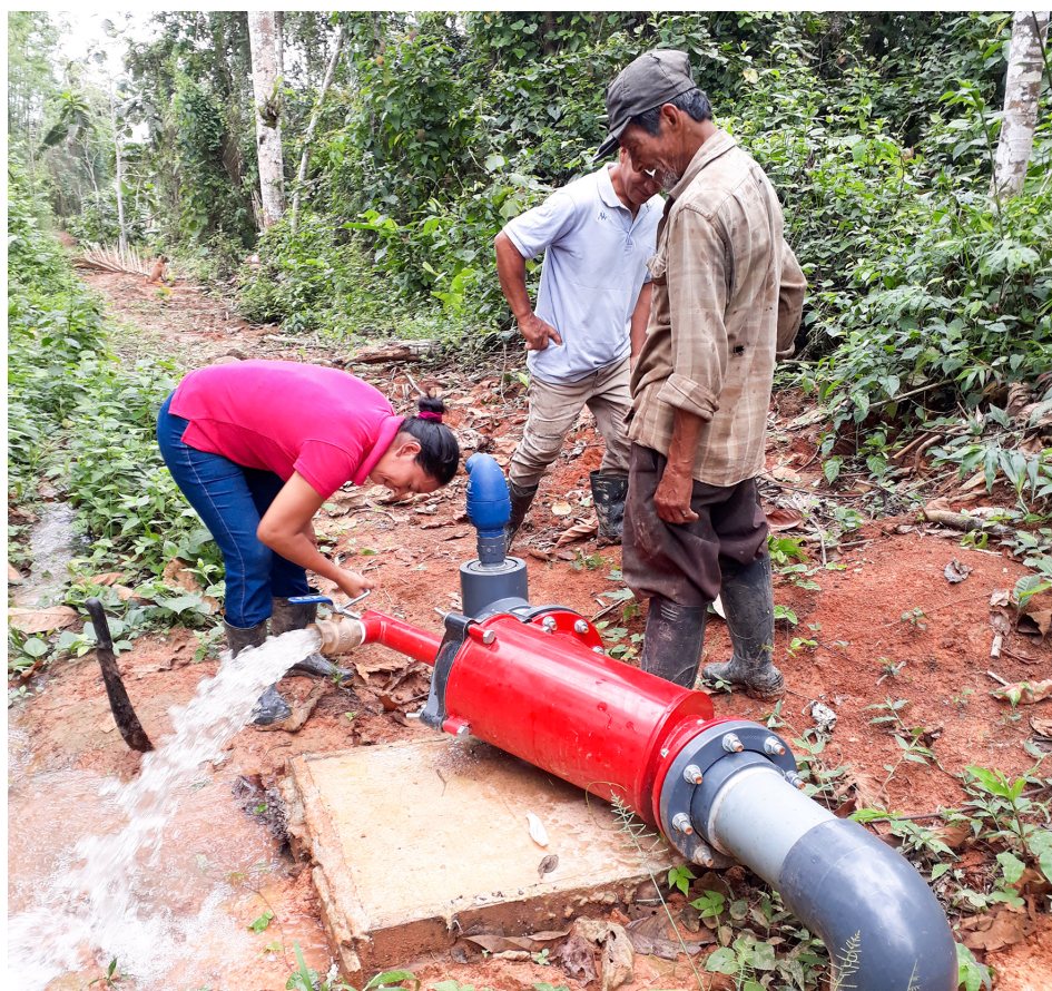
Pasaje – El Oro. Usuaria hace ajustes a la tubería.
