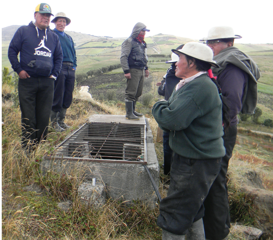
Patacocha – Cañar. Comuneros verifican colectivamente el correcto funcionamiento del sistema de riego parcelario.
