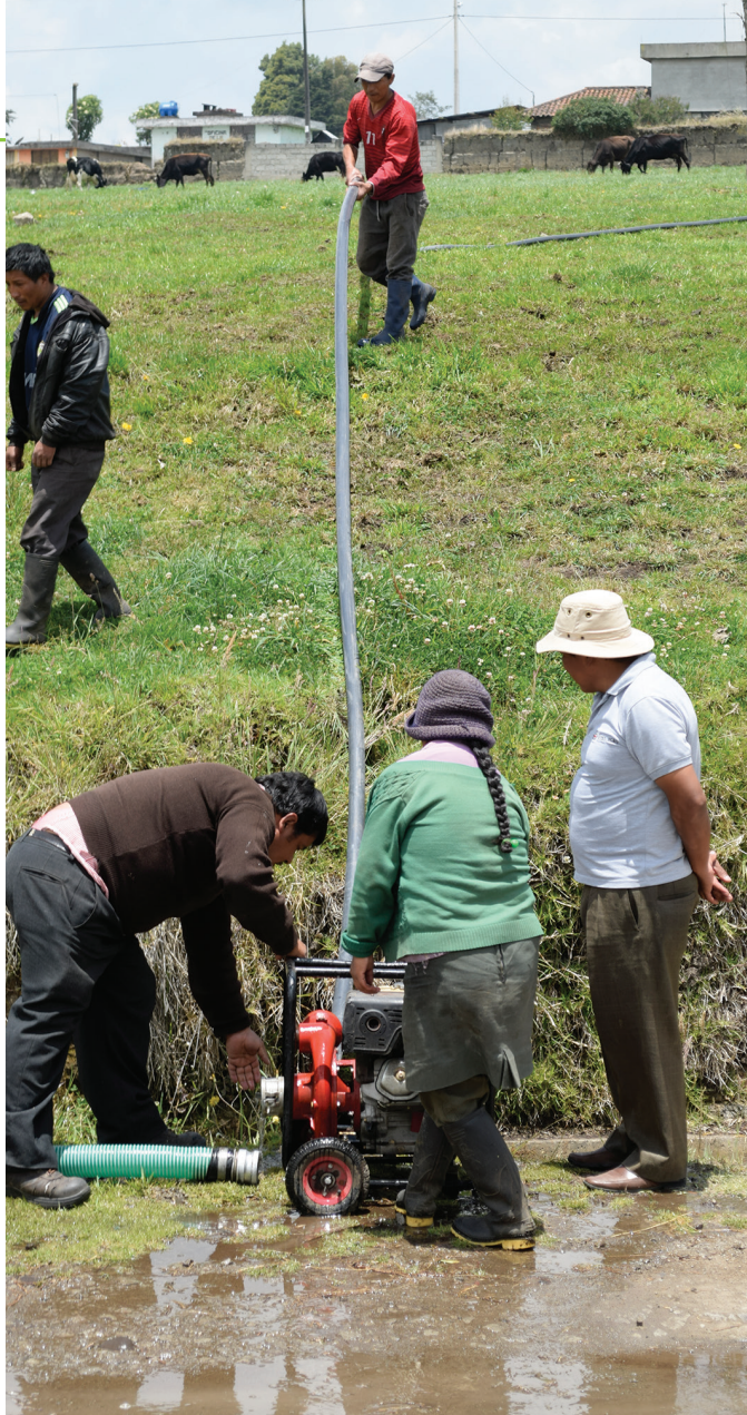
Píllaro – Tungurahua. En los sistemas de riego parcelario tecnificado el mantenimiento es una tarea muy importante. En la gráfica, un grupo de regantes da mantenimiento al canal principal del sistema Píllaro, Ramal Norte.
