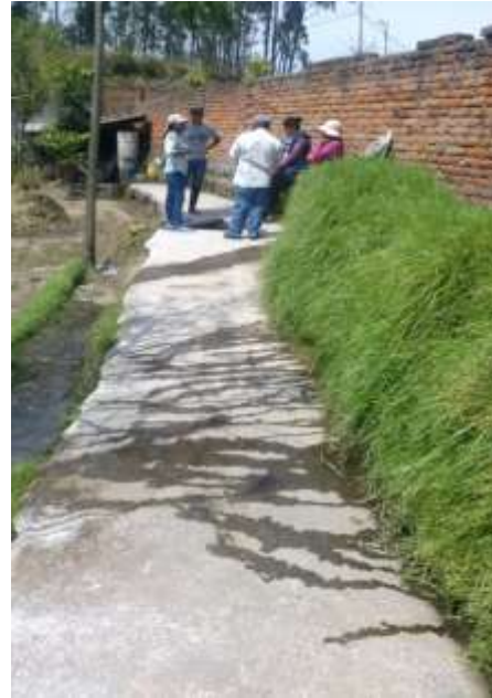
Figura 42. Filtración del agua a través de la pared.
