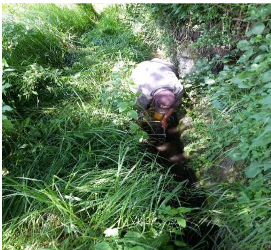
Figura 34. Instalación del vertedero en la entrada del primer usuario.
