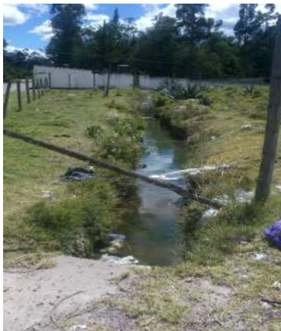
Figura 12. Tramo del canal en propiedad privada.
