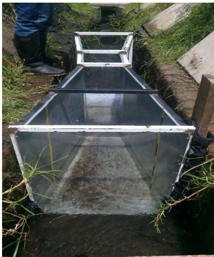
Figura 30. Medición con el canal Parshall en la sección 1 del ramal.
