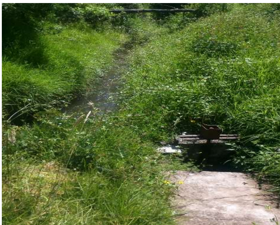
Figura 22. Captación del agua del canal principal hacia al ramal.
