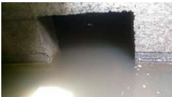
Figura 45. Tramo Inicial de la tubería.
