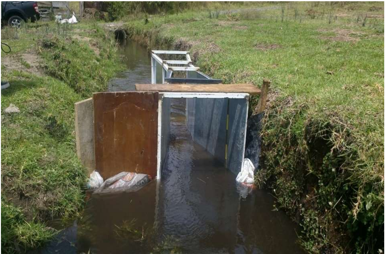
Figura 31. Medición con el canal Parshall en la sección 2 del ramal.
