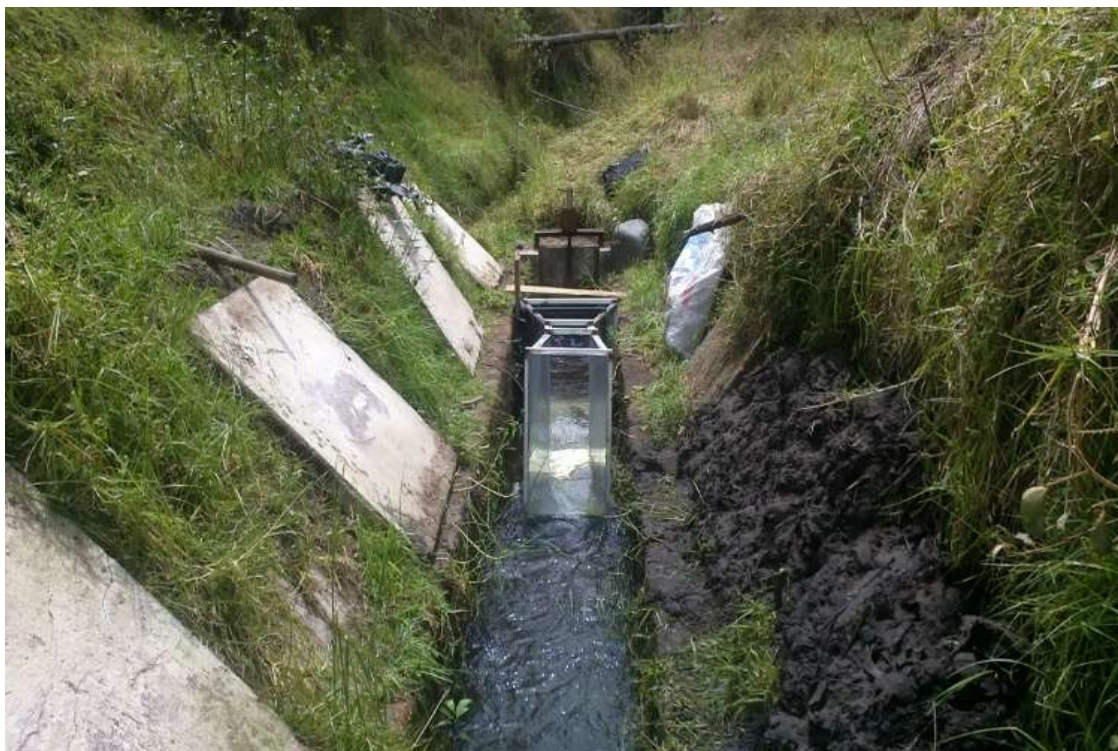
Figura 29. Instalación del canal Parshall en la sección 1 del ramal.
