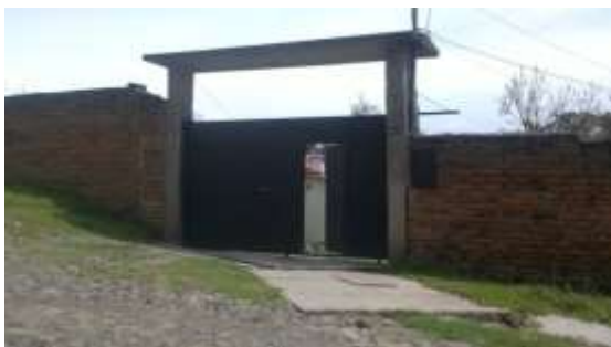
Figura 43. Predio afectado por la mala implementación de la tubería.
