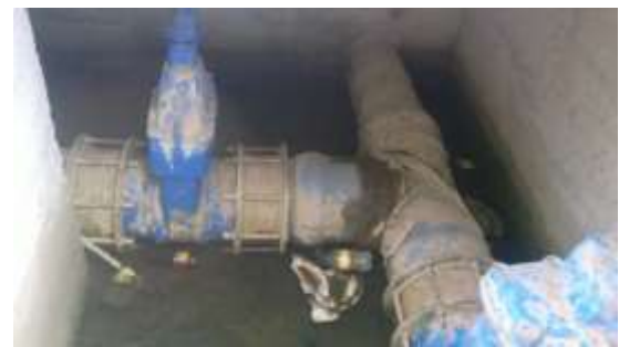
Figura 46. Tramo final de la tubería.
