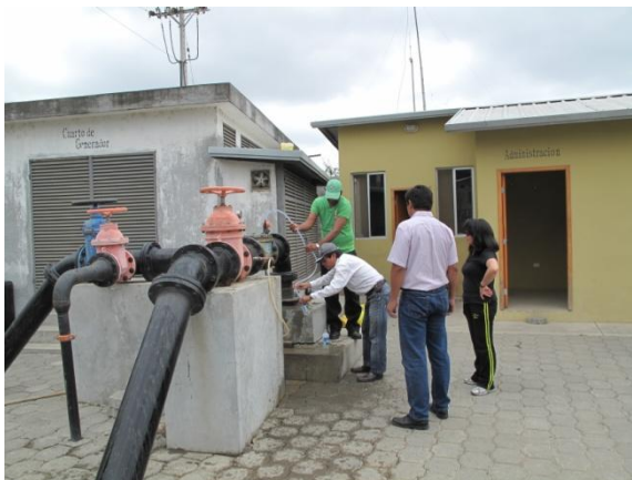
13- Pozo de las 100 camas prof.130 m, después de tanque de depuración
