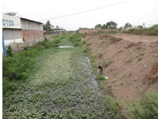
4- Puente del rio Belin
