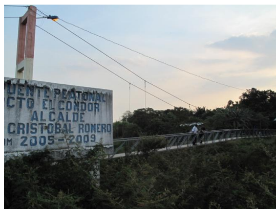
24- Río Milagro en puente recinto El Condor
