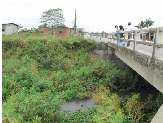
11- Estero 100 camas segundo puente
