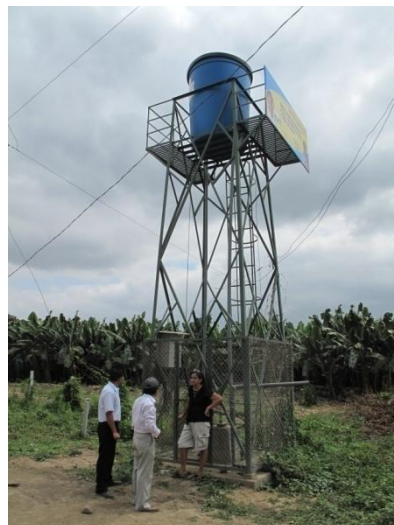
38- Recinto El Paraíso pozo de 90 m de prof.
