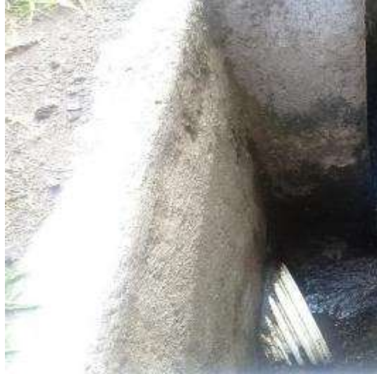
Fotografía 2. Canal secundario entubado
