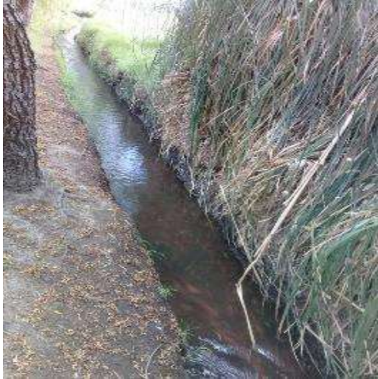
Fotografía 1. Canal secundario sin revestir
