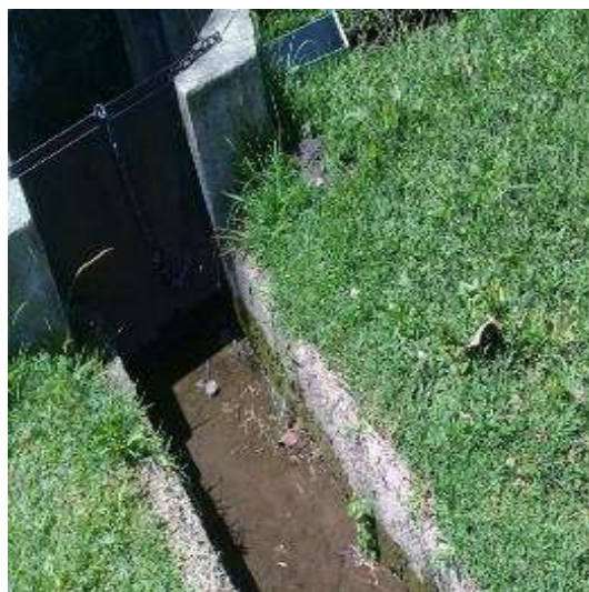
Fotografía 10. Canal terciario embaulado
