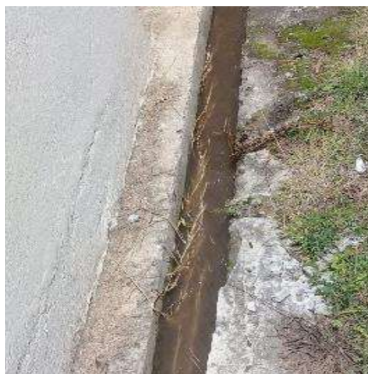
Fotografía 8. Canal terciario revestido
