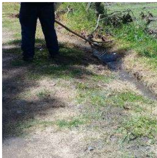
Fotografía 38. Limpieza canal terciario para medición caudal en últimos predios
