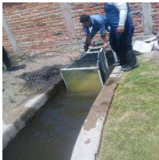
Fotografía 24. Colocación del canal de Parshall en el punto 2
