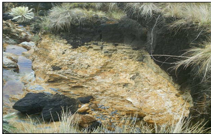
Figura 3.22: Cuando actúa de manera combinada el agua y la gravedad, producen derrumbes de pequeña magnitud en los bordes del canal
