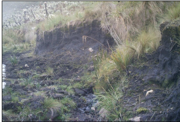
Figura 3.1: Suelo orgánico de textura limo-arcillosa y bloques rodados
