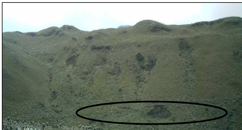
Figura 3.23: Red de cárcavas que generan flujos de lodos en las épocas de fuertes lluvias, el trazado del canal se localiza al pie de la colina.
