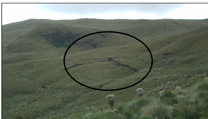
Figura 3.27: Fisura de deslizamiento regresivo que afecta al canal
