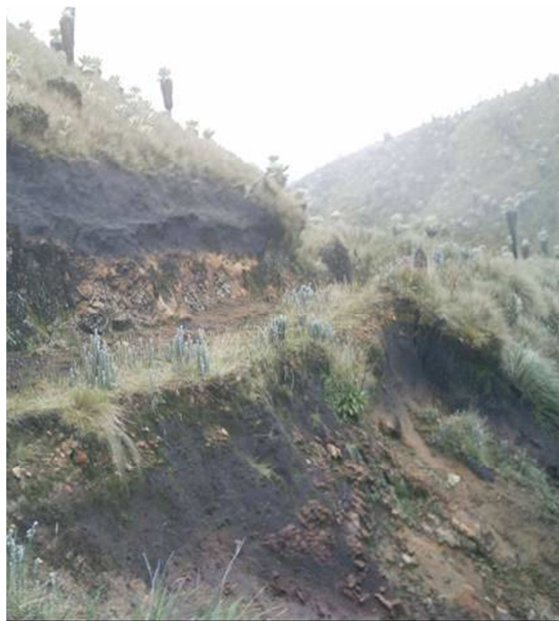
Figura 3.29: Deslizamiento de suelo de pequeña magnitud en el sector Tuquer alto, se observa el contacto entre la roca y el suelo, es precisamente en esta interfase donde se genera el mecanismo desencadenante del deslizamiento incrementado con el corte del talud natural.
