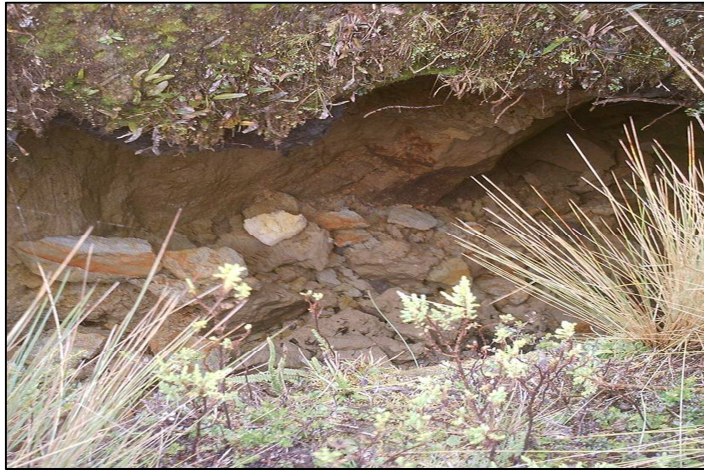
Figura 3.21: Erosión lateral del cauce, provoca caída de los estratos superiores
