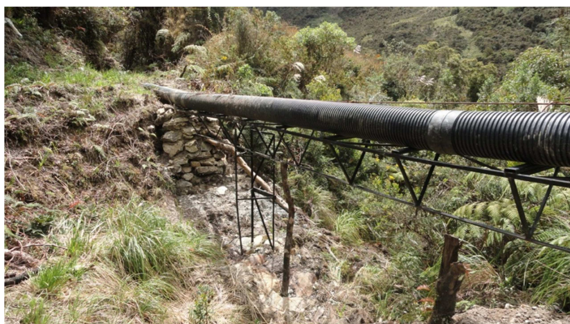
Figura 2.2: Primer paso elevado existente
