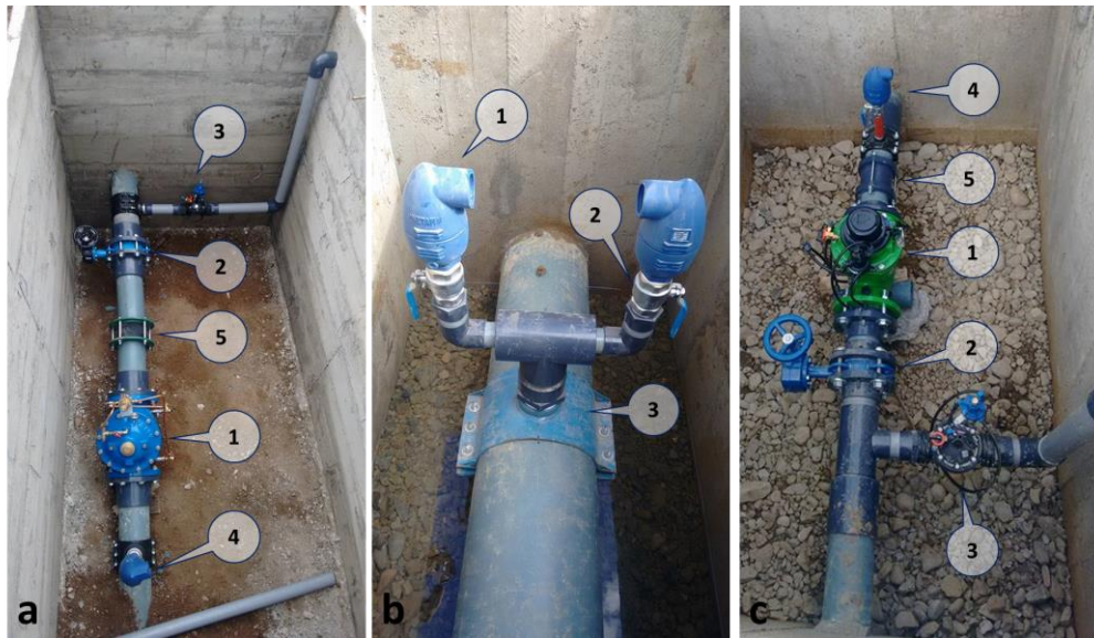
Figura 16. Tipos de válvulas: a) válvula manual; b) válvula de aire (candelabro); c) válvula hidráulica.
