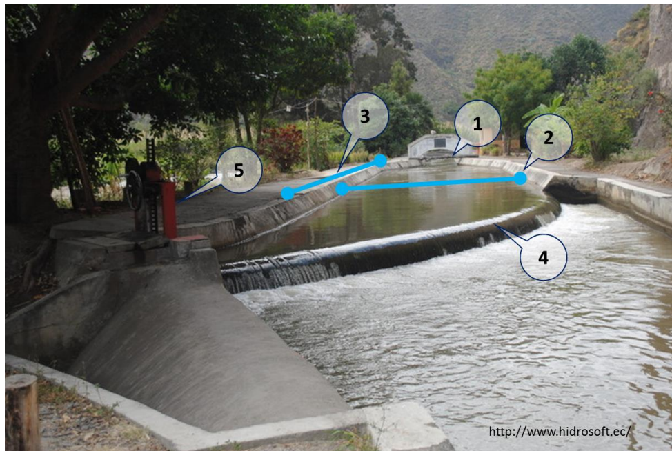
Figura 5. Componentes de un desarenador convencional
