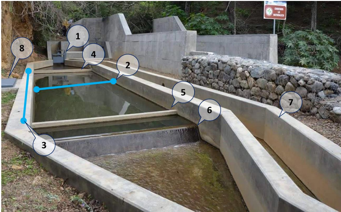
Figura 6. Componentes de un desarenador para riego tecnificado
