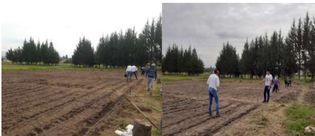
Anexo 12. Instalación de succionadores
