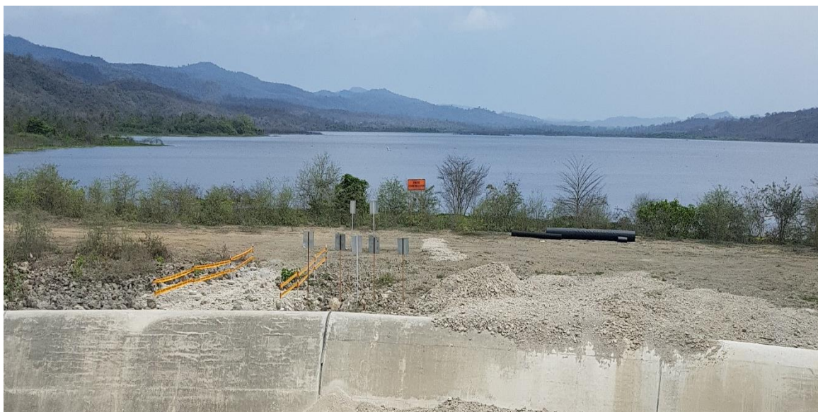
Figura 10. Vista del Embalse San Vicente y de su vertedor Fotografía. Autor
