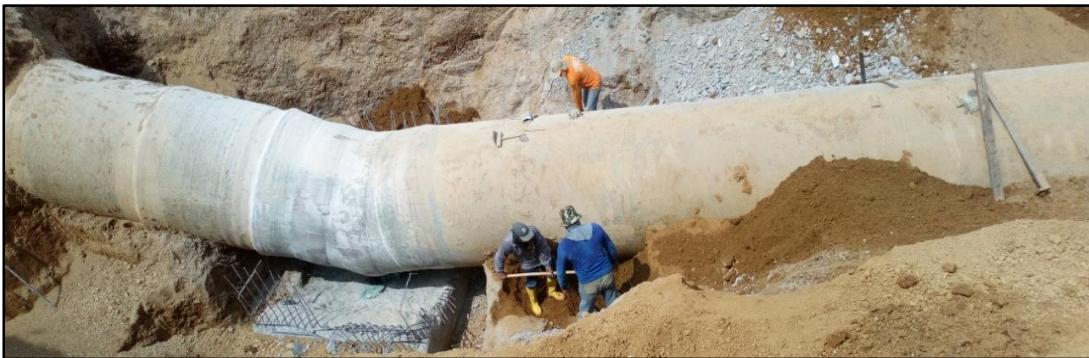
Figura 8. Reparación de la línea de conducción que va de Leoncito al Estero La Camarona. Fotografía: Autor
