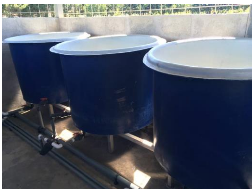
Fotografía 4: Tanques de almacenamiento de fertilizantes
