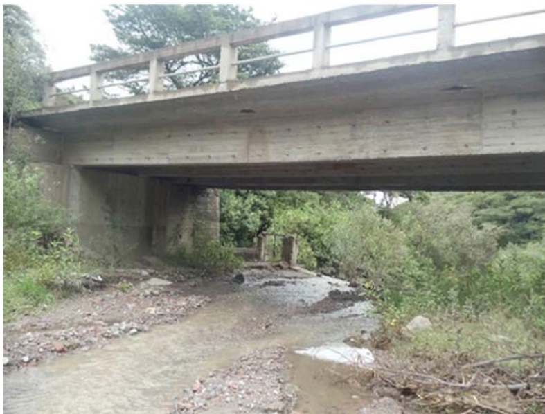
Foto No. 5 Toma de agua Acequia Pigunchuela
