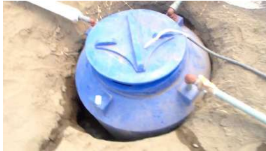
Figura III.16. Tanque de 500lt para realizar la solución 21
