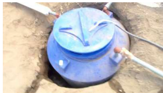
Figura2. Tanque de 500lt para realizar la solución
