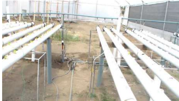
Figura 4. Tubería de distribución hacia los sistemas
