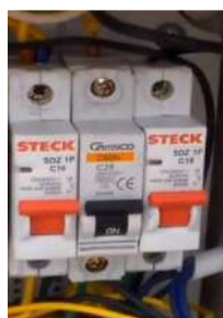
Figura IV.33. Interruptores Termomagnéticos 41
