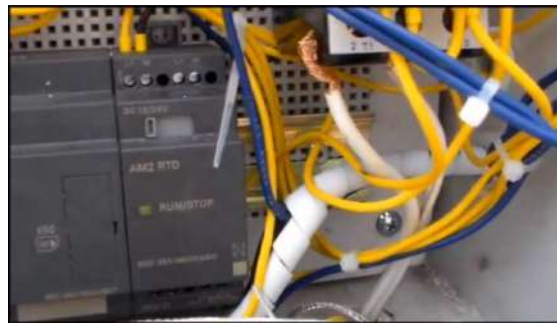
Figura IV.42. Módulo AM2 RTD implementado 52
