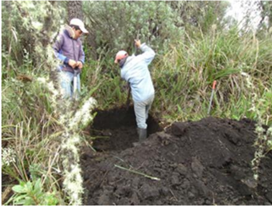
Fotografía 9. Apertura de la calicata 1m por 1.50m y 1.50m de profundidad
