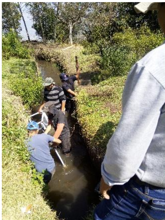
Fotografía 29.- colocación del Parshall
