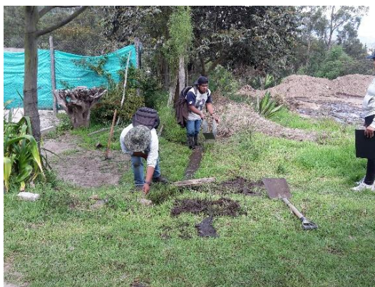
Fotografía 51.- colocación del vertedero
