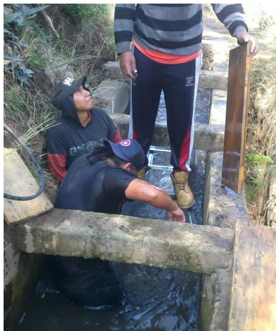
Fotografía 34.- colocación del Parshall
