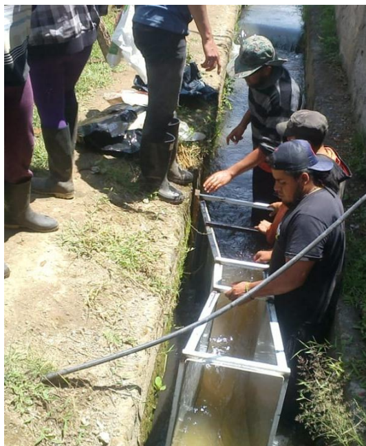
Fotografía 37.- colocación del Parshall
