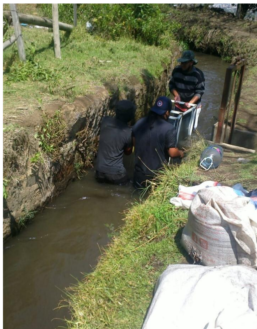
Fotografía 33.- cambio de punto en la sección 1
