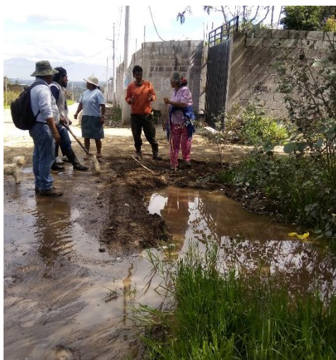
Fotografía 23.- Pérdidas por taponamiento
