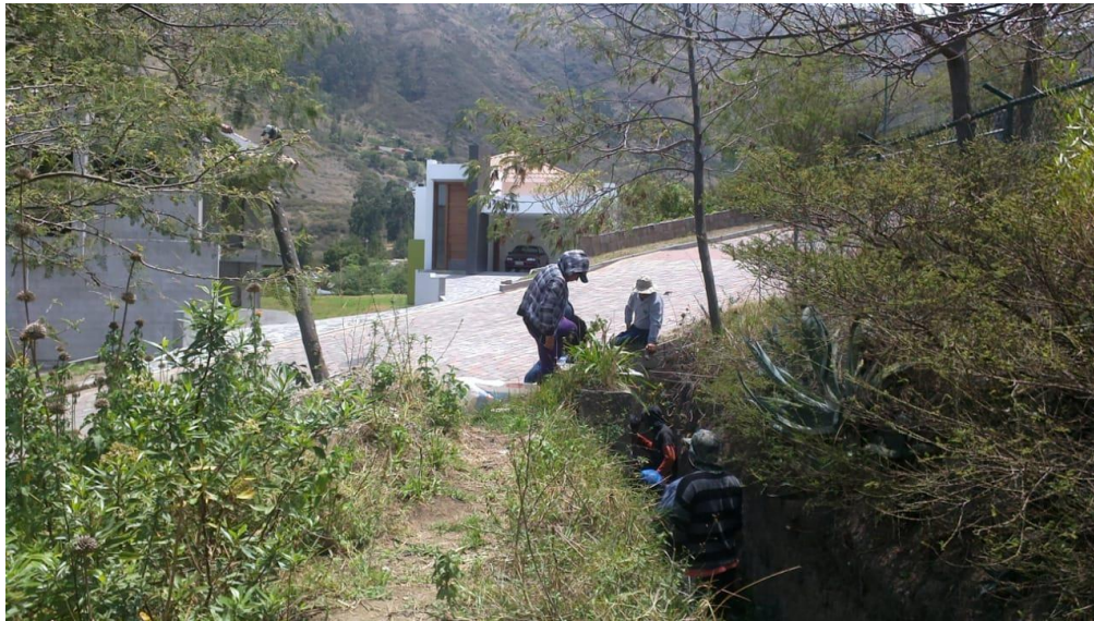
Fotografía 41.- colocación de Parshall en sección 3
