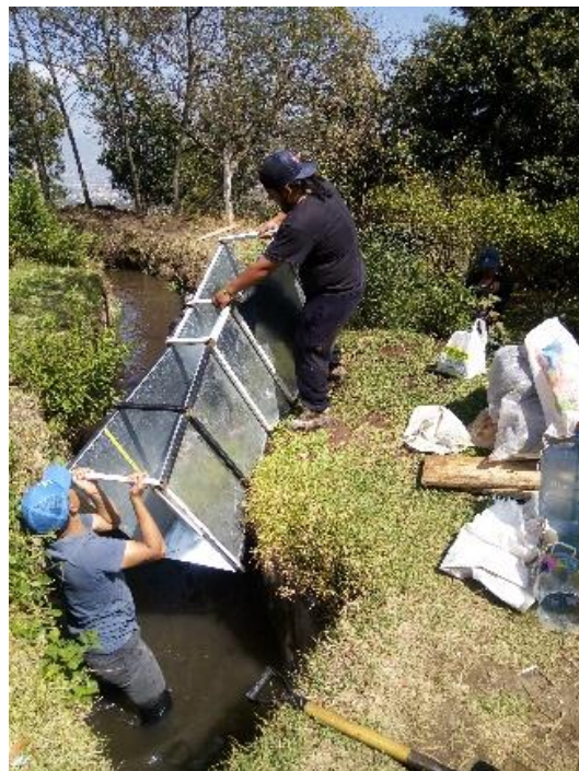
Fotografía 28.- colocación del Parshall
