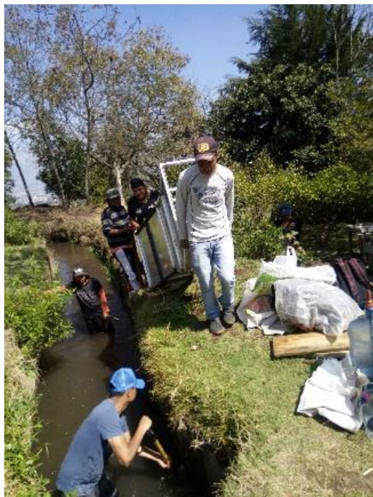
Fotografía 27.- colocación del Parshall
