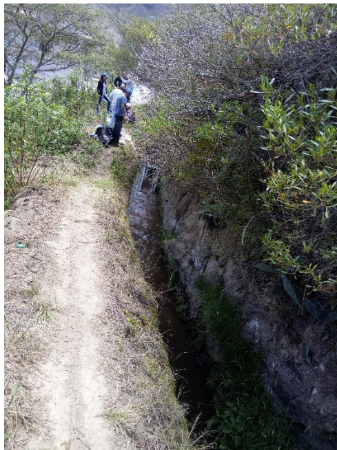
Fotografía 42.- Toma de lecturas en sección 3
