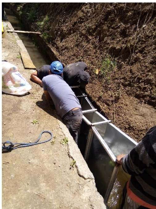
Fotografía 39.- colocación del Parshall
