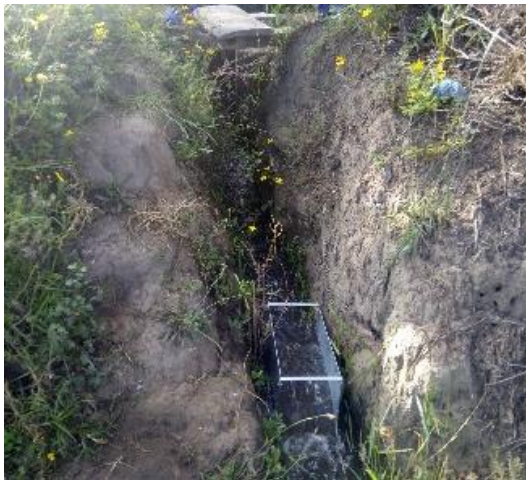
Fotografía 46.- aforo de caudal de entrada al óvalo
