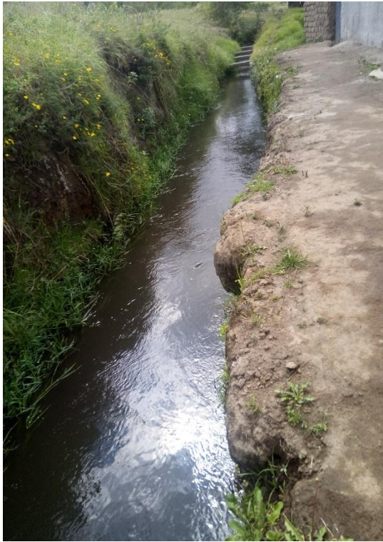
Fotografía 3.- canal sin revestir
