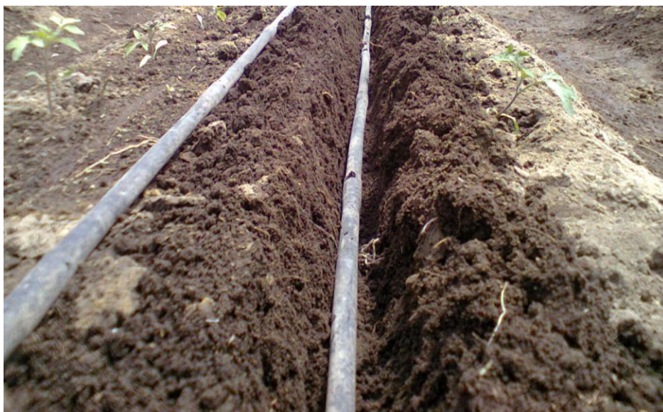
Figura 28. Soterramiento de mangueras de riego.
