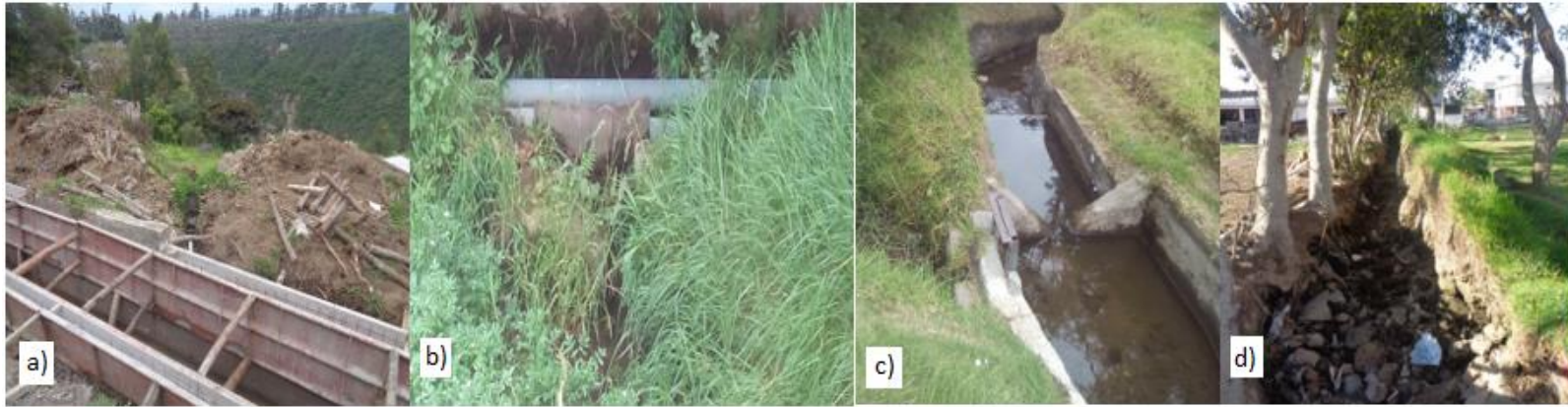
Anexo 3: Respaldo fotográfico de la infraestructura del Sistema de Riego Tumbaco. Ramal Chichipata, zona 1, 2016. a) Canal embaulado. b) Canal entubado. c) Canal revestido. d) Canal abierto.
