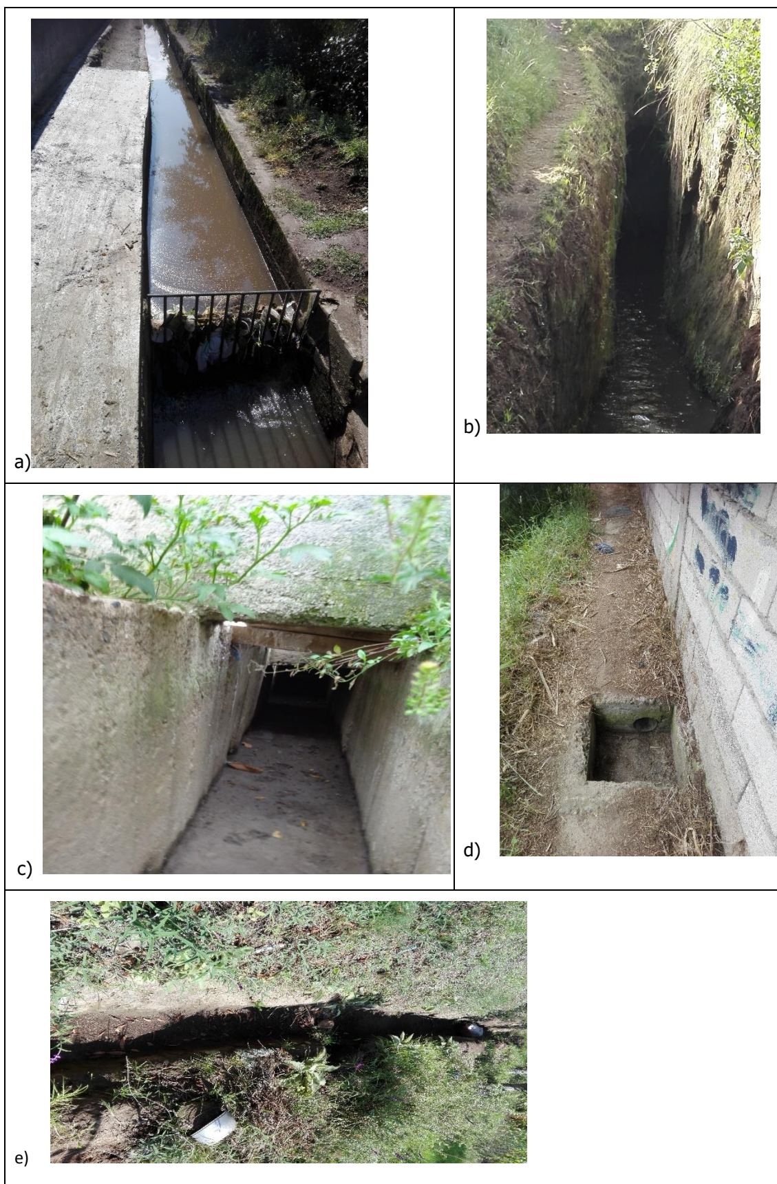
Anexo 9. Fotografías del tipo de infraestructura de los canales de la red de riego Ilaló. a) Canal revestido; b) Túnel y canal de tierra; c) Canal embaulado; d) Canal entubado; e) Canal abierto
