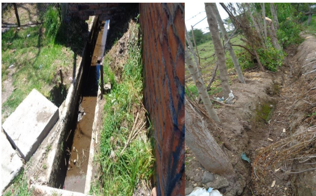
Figura 12. Canal principal. De izquierda a derecha; infraestructura embaulada, revestida y abierto.
