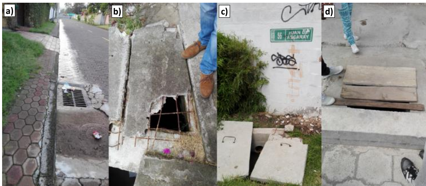
Anexo 26: Fotografías de problemas encontrados en el canal del ramal El Pueblo. a) Desperdicio del agua. b) y c) Infraestructura (tapas) en mal estado. d) Tapas improvisadas.
