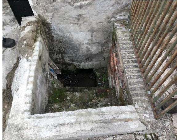
Figura 30. Compuerta de entrada a parcela - División de dos usuarios
