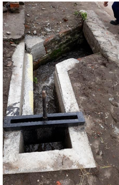
Figura 32. Medición de Caudal entrada a parcela Compuerta – óvalo 3
