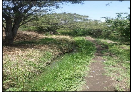
Fotografía 48. Sección no revestida.
