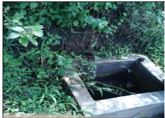
Fotografía 16. Caja de drenaje del agua de riego del ramal Churroloma.
