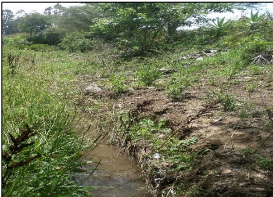
Fotografía 49. Falta de mantenimiento, crecimiento de malezas.
