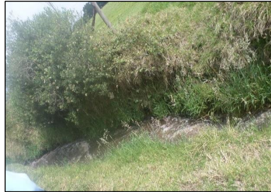
Fotografía 18. Sección del canal irregular no revestido.
