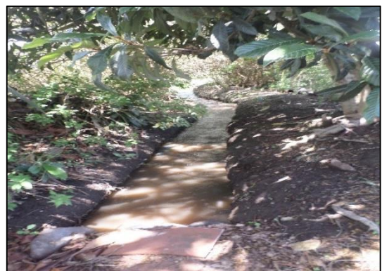
Fotografía 52. Flujo normal, sección conservada, por los habitantes de la zona.
