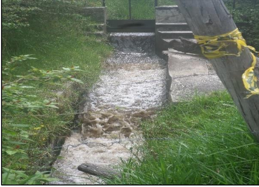
Fotografía 17. Compuerta – canal Churolooma.
