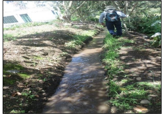
Fotografía 54. Canal homogéneo, Sección de desfogue del agua de riego.
