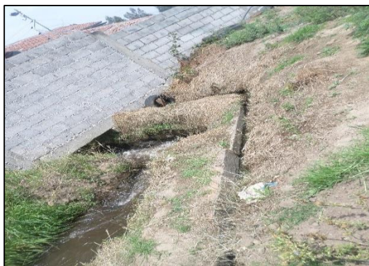
Fotografía 3. Construcción de viviendas sin respetar la norma.
