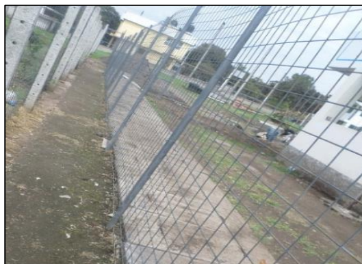
Fotografía 10. Sección revestida, embaulada, atraviesa propiedad.
