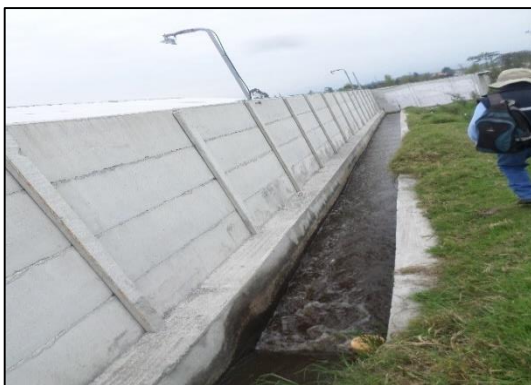
Fotografía 21. Sección revestida, construida por el propietario del inmueble.
