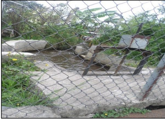
Fotografía 23. Compuerta de división, hacia los ramales de El Pueblo y San Blas.
