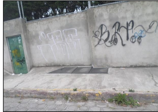
Fotografía 24. Compuertas embauladas, división de los dos ramales.
