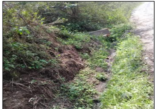
Fotografía 56. Zona de drenaje.
