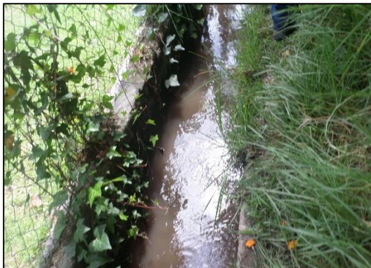
Fotografía 43. Sección tipo tierra, falta de mantenimiento.
