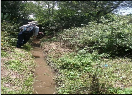
Fotografía 47. Sección no revestida homogénea crecimiento de kikuyo en los bordes.
