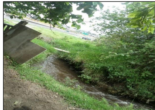
Fotografía 26. Tubería, que atraviesa la ruta viva.
