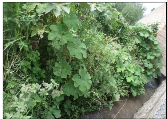
Fotografía 44. Sección crítica desbordes de agua
