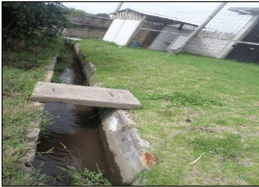
Fotografía 41. Sección revestida, presencia de sedimentos.
