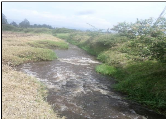
Fotografía 1. Sección irregular, presencia de desbordamientos.
