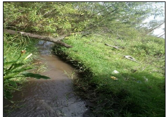
Fotografía 46. Sección irregular, frecuencia de desborde y obstrucciones por material vegetal.
