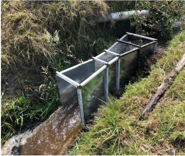
Figura 31. Medición de caudal de entrada al ramal con el medidor Parshall
