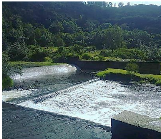
Figura 1. Bocatoma a la altura de Alangasí.
