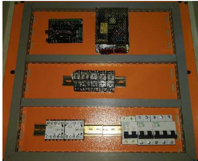
Figura 17- 2: Distribución de canaletas y carril Din
