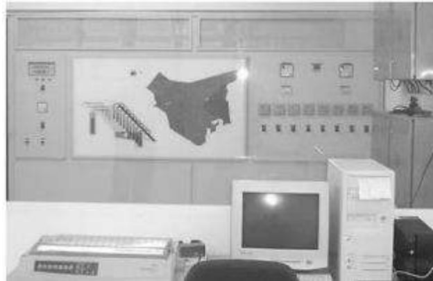
Figura 5-1. Centro de control de riegos
