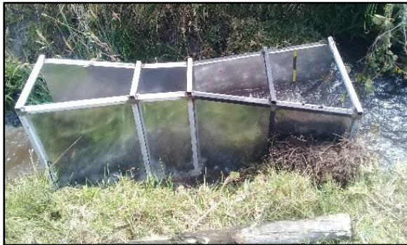
2. Prueba de Aforo de caudal.
