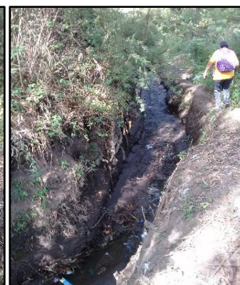
12. Falta de limpieza
