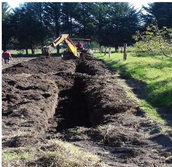
Anexo 3: Zanjas para colocación de la tubería principal y múltiples
