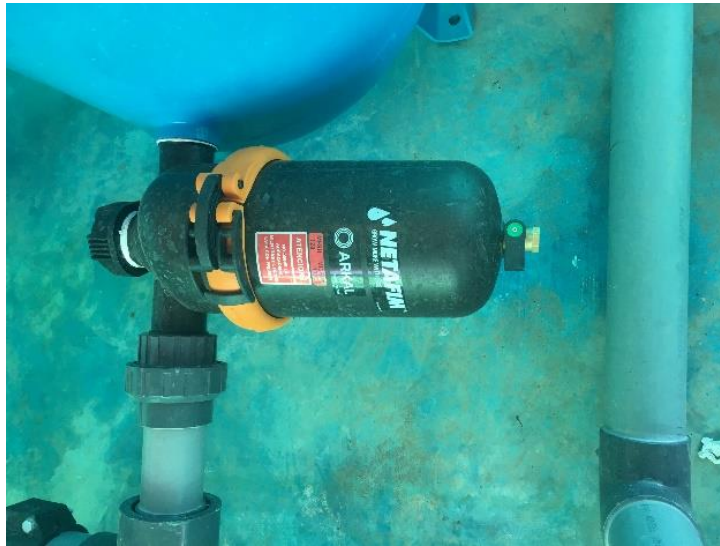
Anexo 18: Limpieza del filtro de anillas
