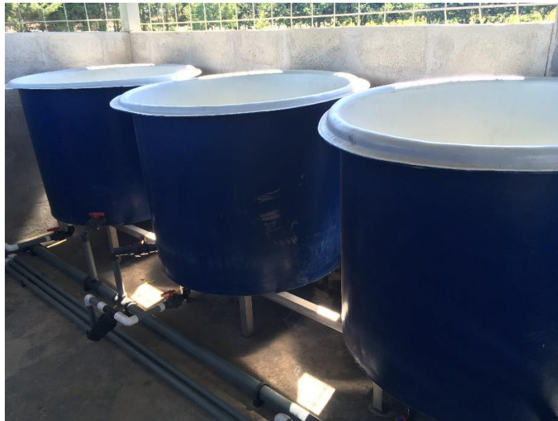
Anexo 20: Tanques para preparar la solución madre del fertilizante y regulación del pH del agua de riego.
